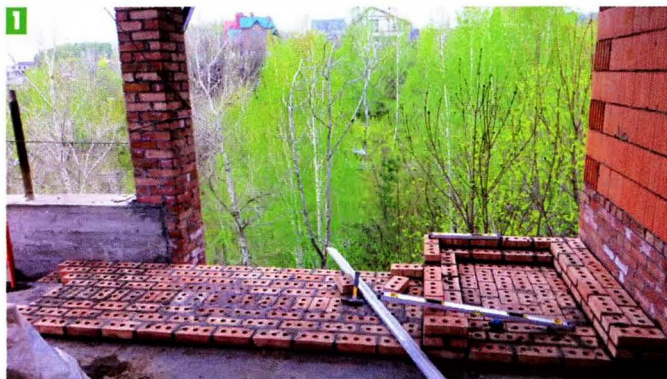
1 Работу Александр начал с того, что выложил нулевой ряд сразу под весь комплекс.
