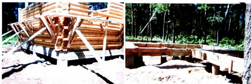
Фото: строительство коттеджа на столбчатых фундаментах с ростверком, приподнятым над грунтом.
