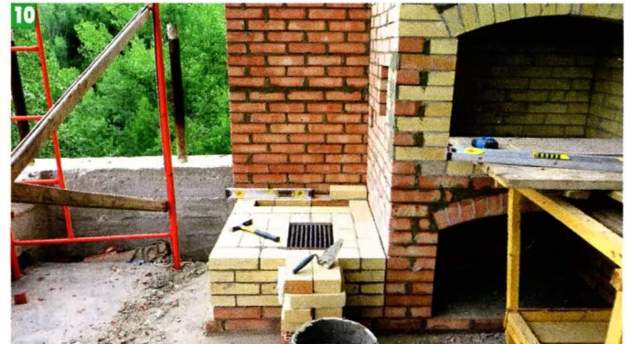
10 Возведение последней, четвёртой части комплекса — печи под казан.
