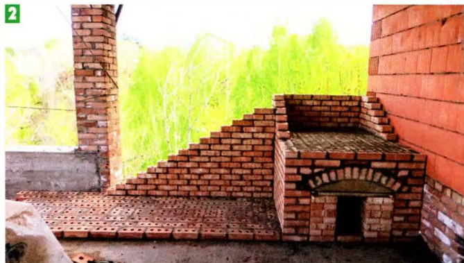
2 В нижней части русской печи сделано довольно вместительное хранилище для дров.
