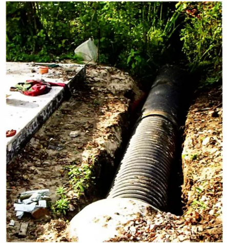
Для расширения въезда на участок соединили железобетонную и стальную, покрытую гидроизоляцией, трубы.
