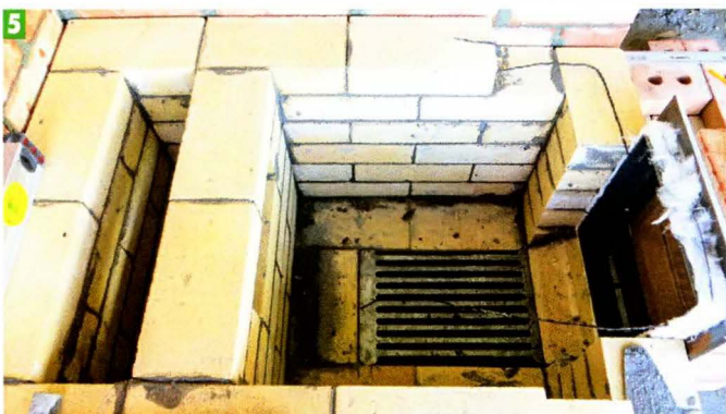
5 Выложена топочная камера коптильни.
