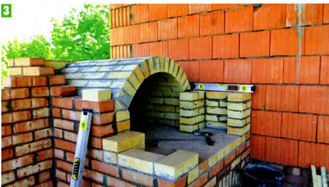
3 Топка русской печи глубиной около 90 см была спроектирована и выложена в точном соответствии со всеми канонами и нормами.
