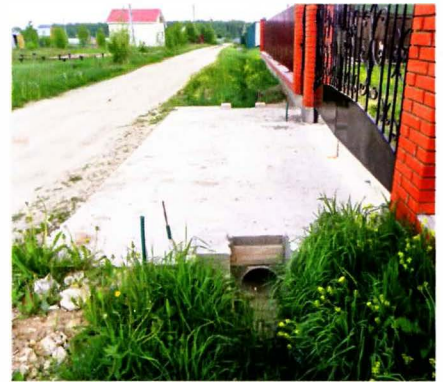
Для расширения въезда на участок соединили железобетонную и стальную, покрытую гидроизоляцией, трубы.
