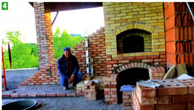
4 После завершения кладки русской печи мастер сразу же приступил к возведению печи-коптильни.
