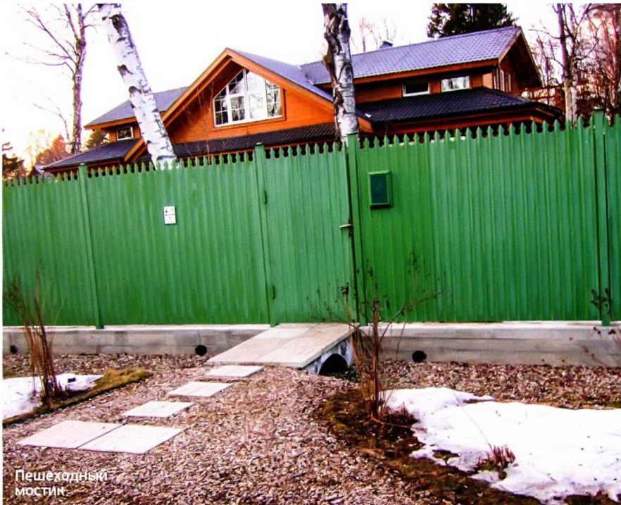
Для расширения въезда на участок соединили железобетонную и стальную, покрытую гидроизоляцией, трубы.
